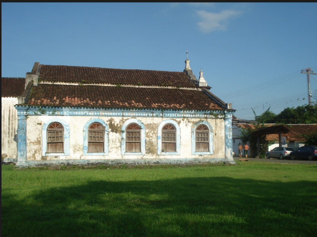
Figura 5 - Sacristia da Igreja de São Sebastião de Porto de Cima/Paraná. Foto: Cláudia Eliane Parreiras Marques Martinez, 2010.
